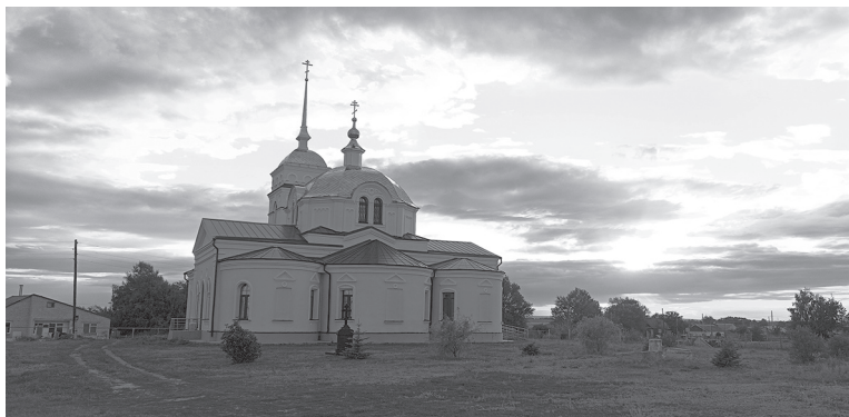
Рис. 1. С. Липовка. Современное состояние церкви Покрова Богородицы. Фото автора
